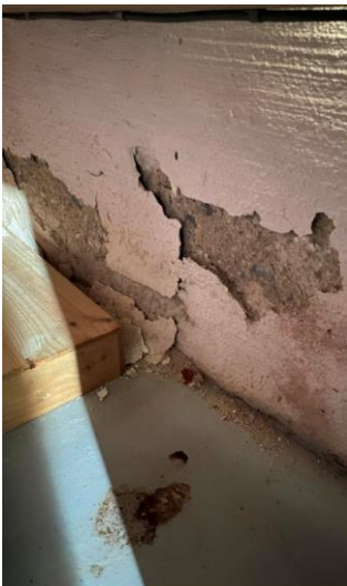
Fugtafskalning på kældervæg
