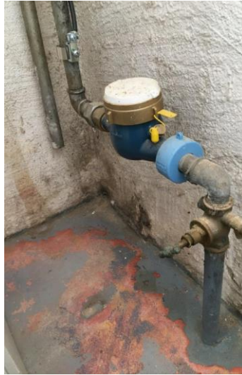
Skimmelvækst på væg ved vandmåler
