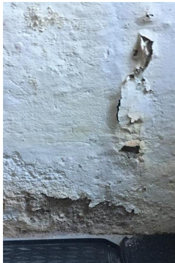
Fugtafskalning på kældervæg
