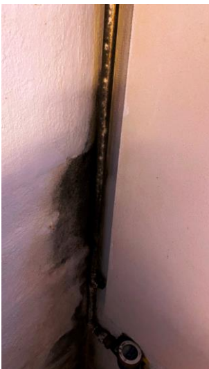
Skimmelvækst på væg ved vandmåler
